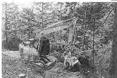
現場で稼働するSK135SR-2F
